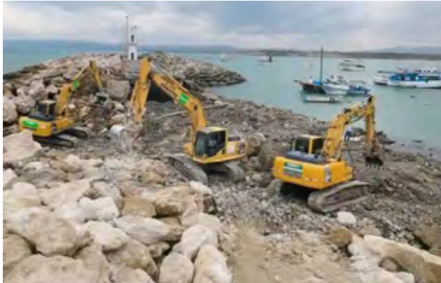
Maquinaria en labores para reparación de puerto.
