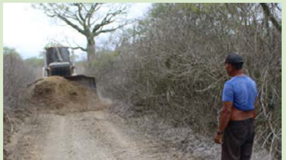
Maquinaria abriendo camino y despejando excesos de tierra.
