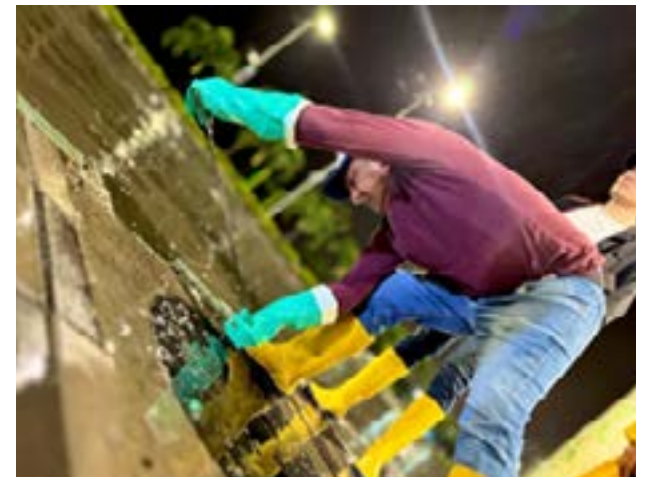
Limpieza en la avenida Malecón: sifoneros trabajan para eliminar la acumulación de arena en los ductos, asegurando una evacuación eficiente del agua.
