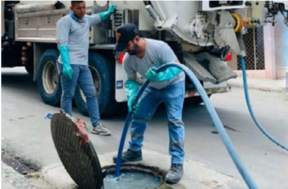
Limpieza de sumideros en acción: una labor que requiere la colaboración de todos para evitar inundaciones durante la temporada de lluvias.
