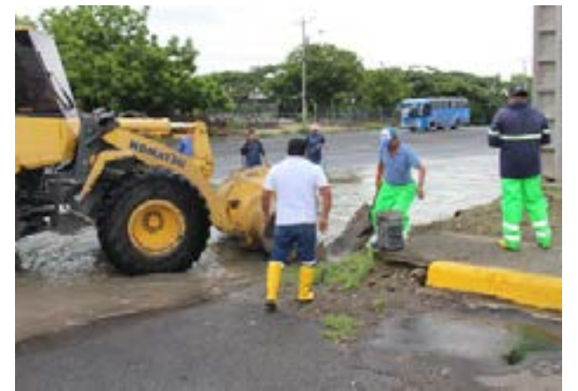
Los técnicos realizan trabajos de limpieza en los canales de drenaje para evitar acumulaciones de agua en las zonas bajas de la ciudad.
