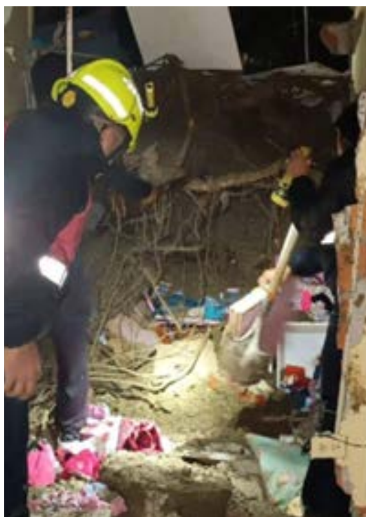
Así quedó la vivienda después del colapso.
