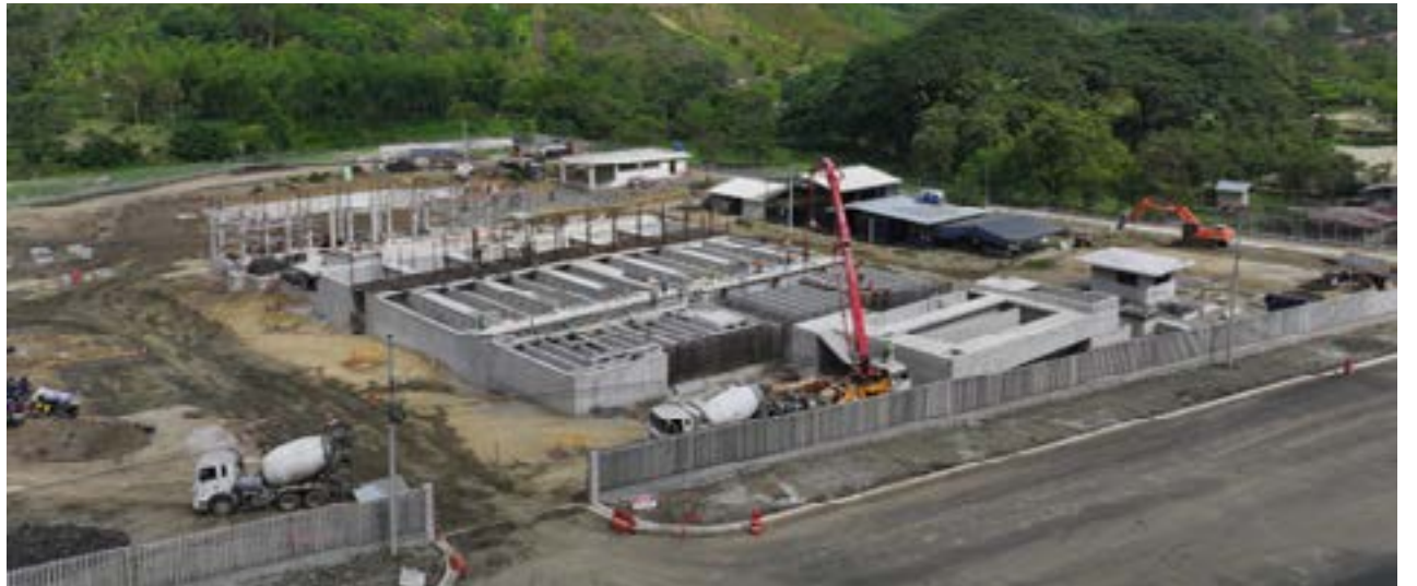
Así se aprecia el avance de la infraestructura.
