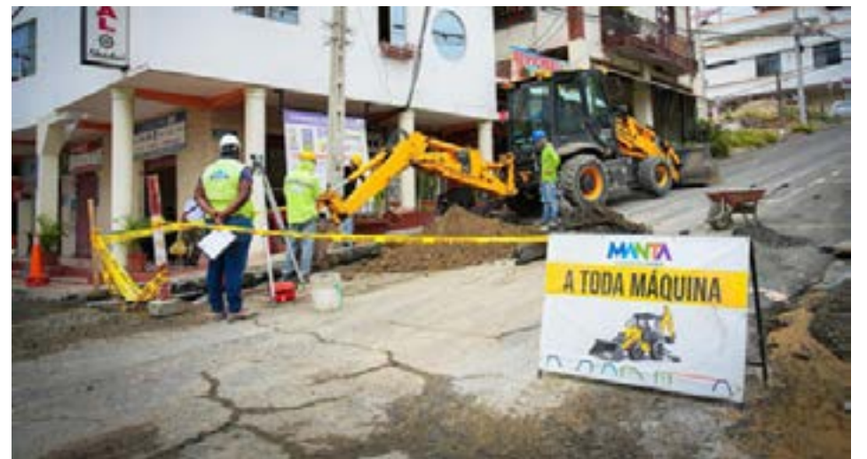
Los trabajos de instalación de nuevas redes de aguas servidas y agua potable, confiados en que los beneficios se verán a largo plazo.
