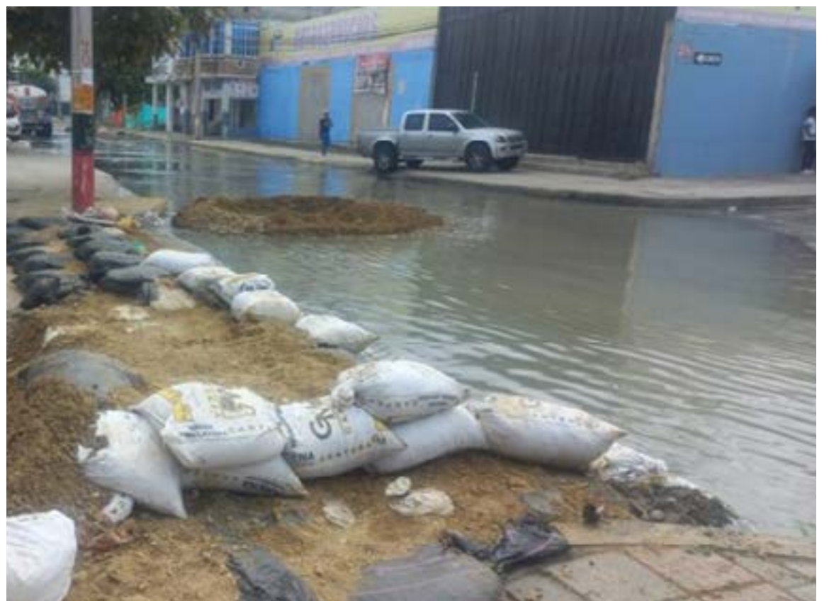
Aguas servidas inundan la avenida 102 en Los Esteros, afectando a los residentes del sector con graves problemas de insalubridad.
