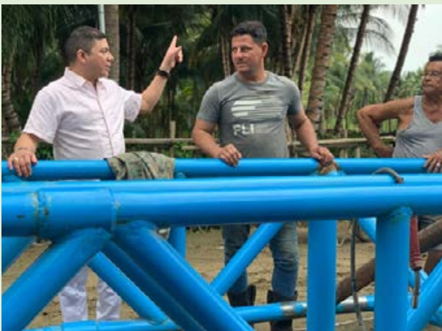
Alcalde del Cantón inspeccionando la obra.
