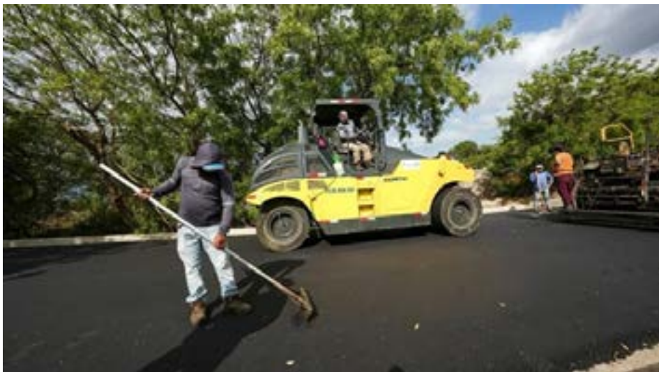
Trabajos de asfaltado en la nueva calle de Barbasquillo que conecta con la ciudadela Los Eléctricos y la universidad Eloy Alfaro de Manabí.
