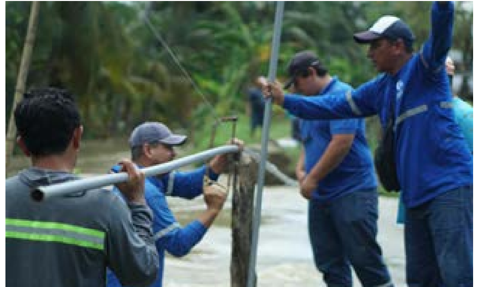
Personal de Epapar en la instalación de la tubería colgante.
